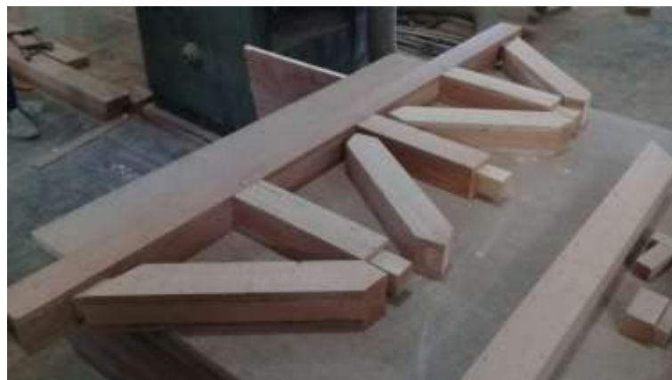
Gambar 5.4 Perakitan elemen-elemen box beam
