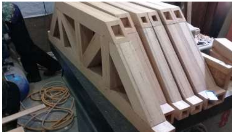
Gambar 5.6 Perakitan elemen-elemen box beam menjadi jembatan rangka kayu box beam
