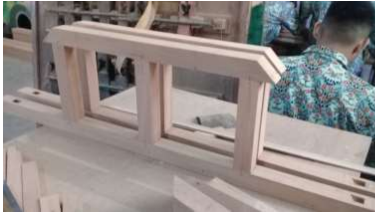
Gambar 5.5 Perakitan elemen-elemen box beam
