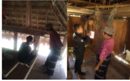
Gambar 12. Terlihat adanya bukaan untuk aliran udara masuk pada rumah besar (kiri), interior rumah adat biasa cukup rapat (kanan)
