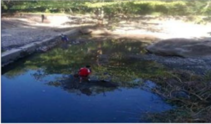
Gambar 1. Bagian hilir Bendung Waikomo
