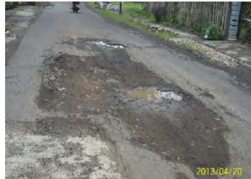
Gambar 1. Kondisi jalan di Kecamatan Wates yang rusak akibat limpasan permukaan
